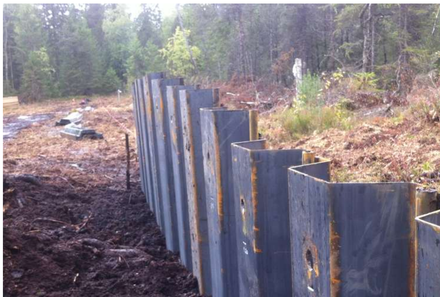
Pose d'une cloison métallique Tourbière de Frasne (France, 25)
